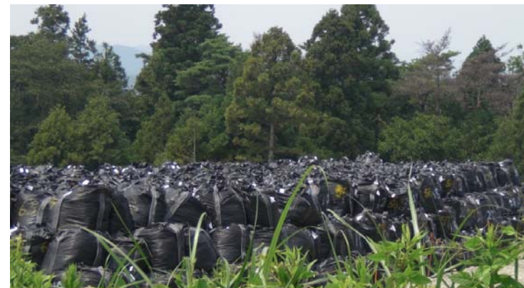
がれき・除染土の収納されたコンテナバッグ仮置き場
