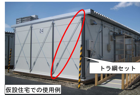
【ターンバックルブレース】
