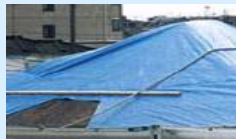
ブルーシート・土のう袋類
