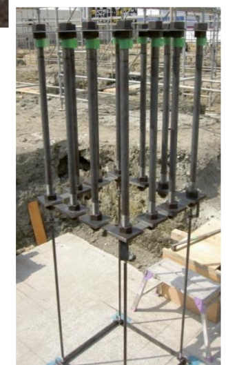
Anchor frame (Kon-base Eco)
