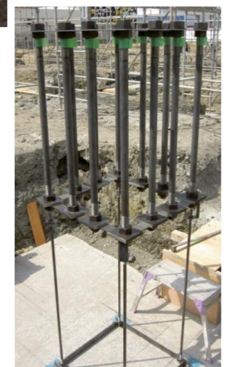
Anchor frame (Kon-base Eco)
