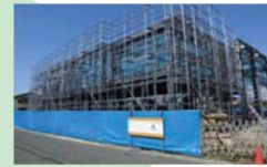
◀ 足場架設工事
