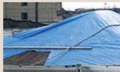
ブルーシート・土のう袋類
