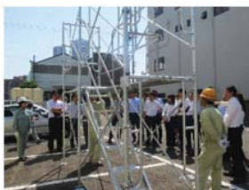
仮設資材研修での組み方実演
