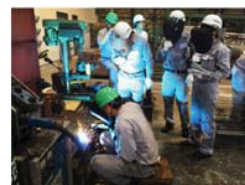
↑鉄骨資材研修での溶接実習
