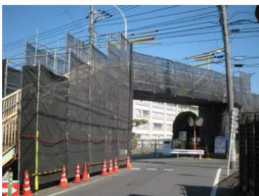
陸橋改修工事
