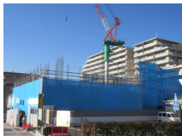
マンション新築工事
