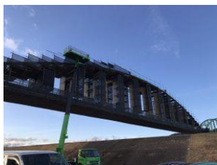
水道橋 改修工事
