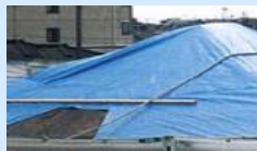
ブルーシート・土のう袋類
