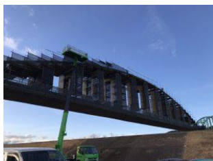
水道橋 改修工事
