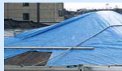
ブルーシート・土のう袋類
