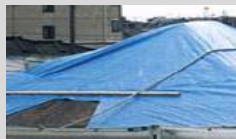
ブルーシート・土のう袋類
