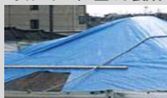
ブルーシート・土のう袋類
