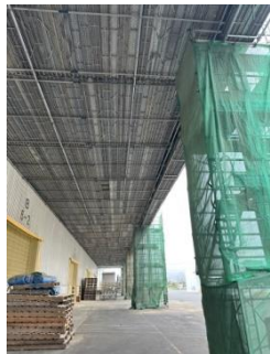
埠頭工事現場(吊り足場)
