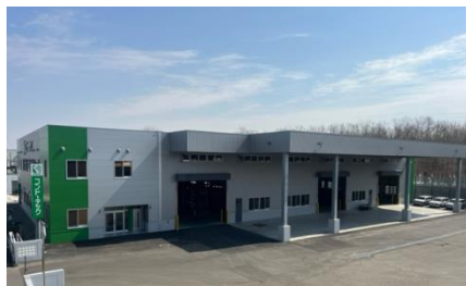
(札幌支店、札幌工場の敷地内に設置)
