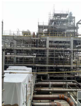
バイオマス発電所工事現場
