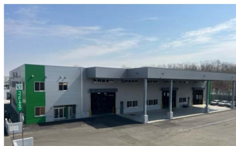
(札幌支店、札幌工場の敷地内に設置)
