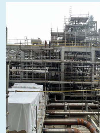
バイオマス発電所工事現場
