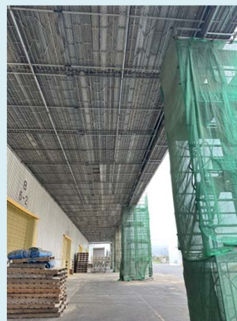
埠頭工事現場(吊り足場)
