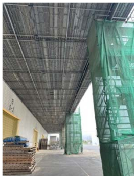
埠頭工事現場(吊り足場)
