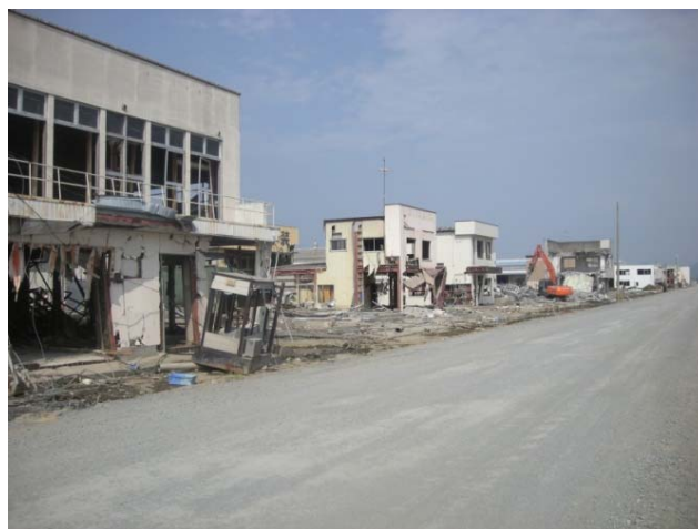
震災現場：鉄骨造が見直されるきっかけとなった。
