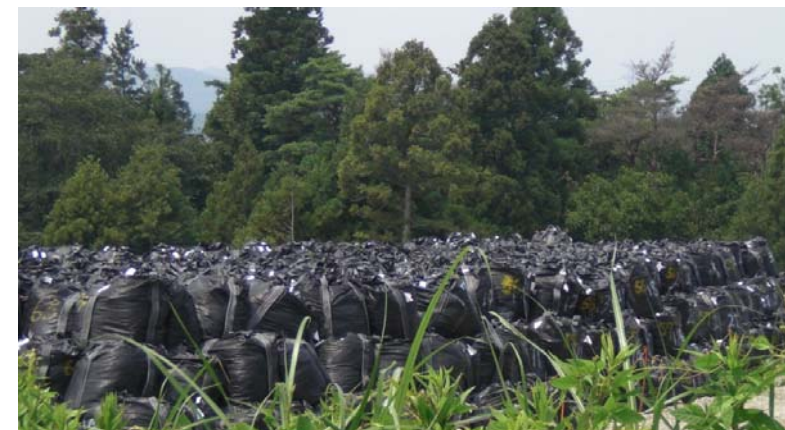
がれき・除染土の収納されたコンテナバッグ仮置場の様子
