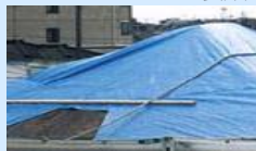
ブルーシート・土のう袋類
