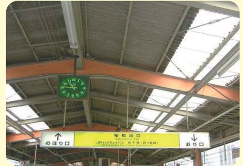
駅のホームの屋根での使用風景
