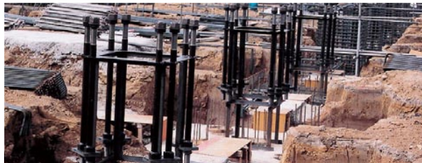
（建築現場での使用風景）
