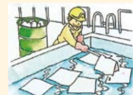
分離槽の浮上油の除去
