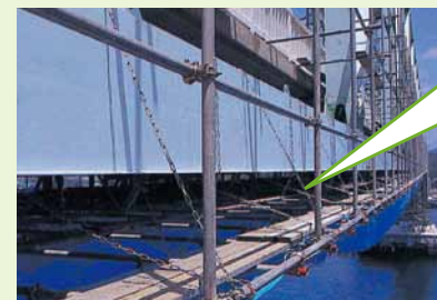
海上にある橋の足場での使用風景
