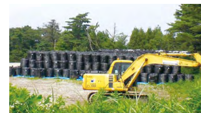
汚染土壌の貯蔵に使用された大型土のう
