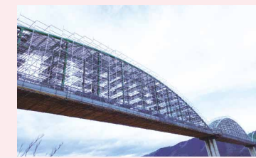
橋梁での足場工事施工例
