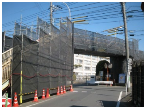
足場工事施工例
