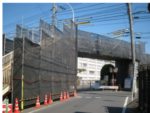
足場工事施工例
