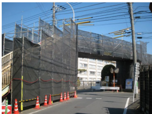
足場工事施工例
