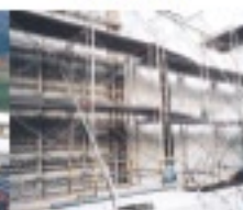
土木建築工事
