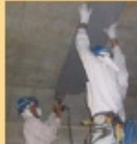
・地下鉄天井工事
