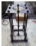
アンカー埋込完了
