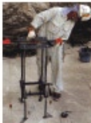
アンカー埋込作業
