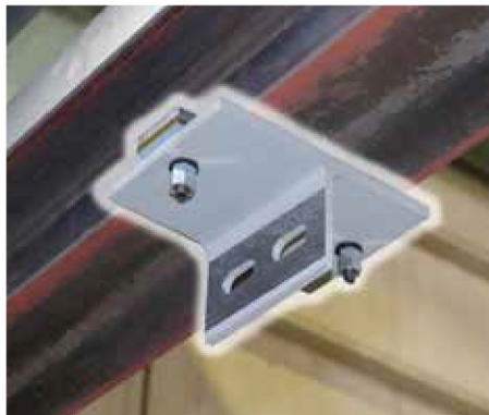
鋼球支圧接合による新しい発想の横滑り抑制技術
