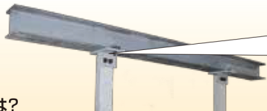
鋼球支圧接合による新しい発想の横滑り抑制技術
