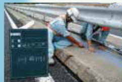
中央分離帯遊間の防水
