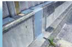
壁高欄縦目地の防水
