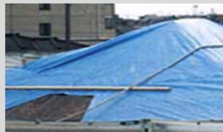
ブルーシート・土のう袋類
