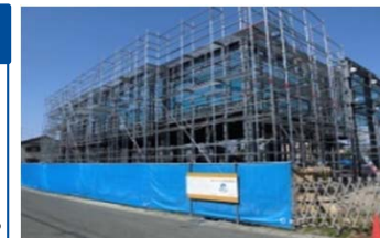
◀ 足場架払工事
