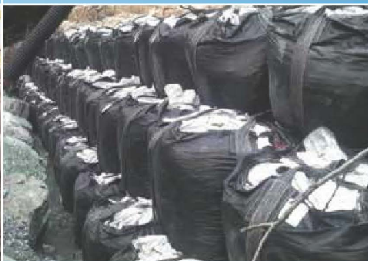
耐候性大型土のう
