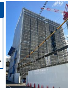
足場架設工事
