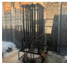
▲ 鉄骨基礎部材
