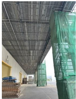
埠頭工事現場(吊り足場)
