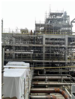
バイオマス発電所工事現場
